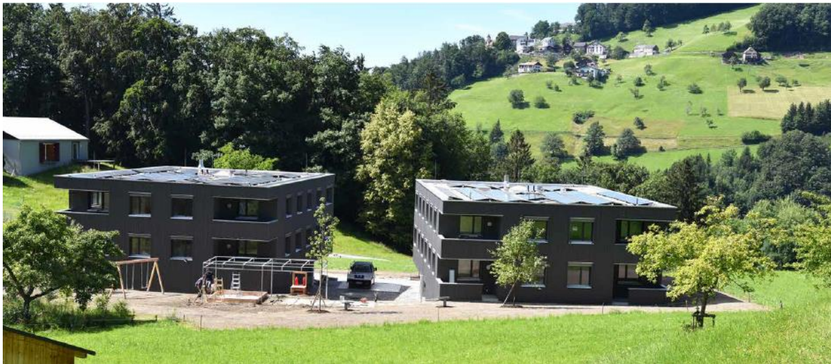
Abbildung 11: Mehrfamilienhäuser in Dafins. Haus A (links), Haus B (rechts); PV-Anlage, E+1, je 6 Wohnungen. (Foto: Energieinstitut Vorarlberg)
