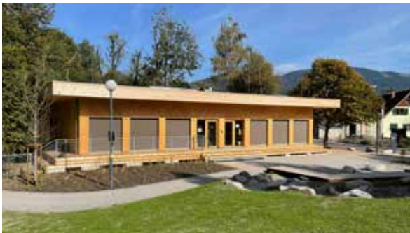
In nur sieben Monaten wurde der eingeschossige Pavillon in Holzbaweise errichtet - mit 300 Festmeter heimischem Fichten- und Tannenholz der Stadt Dornbirn. © Fotos Stadt Dornbirn
