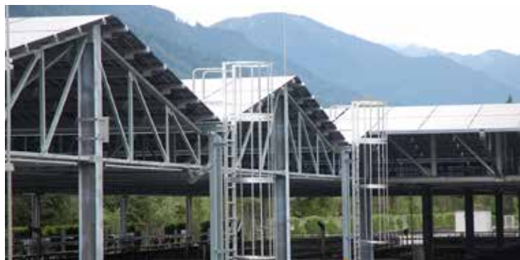
Die aufgeständerte PV-Anlage ist einzigartig in ganz Österreich. Ein PV-Dach mit 800 kWp Leistung liefert Sonnenstrom. Dazu wurden 1.864 Solarmodule installiert. Zusätzliche PV-Module befinden sich auf dem Dach der Nebengebäude.
