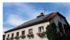
Gemeindeamt Mäder: 10,5 kWp
