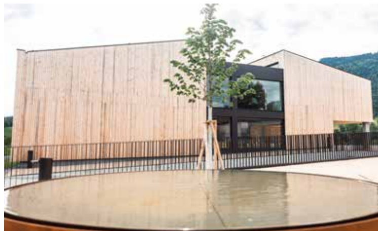
Neubau und Sanierung der Volksschule Hof in Andelsbuch (© Gemeinde Andelsbuch, Frederic Sams)
