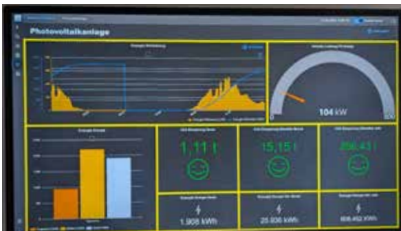
Das Solardach der ARA Ludesch deckt den Strombedarf zu fast 80 Prozent. Etwaige Überproduktionen werden ins heimische Stromnetz eingespeist.
