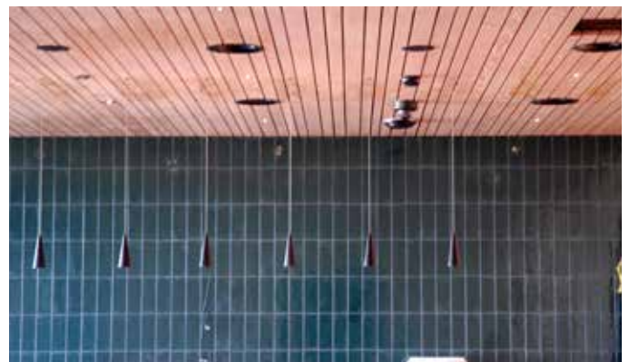
Der Innenausbau kann sich sehen lassen. Die eindrucksvolle Pyramiden-Holzdecke dient zum Schallschutz und versteckt das ausgeklügelte Lüftungssystem.
