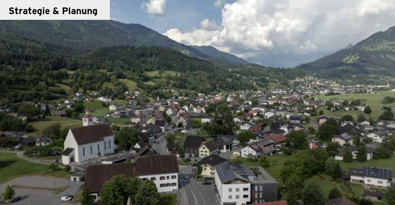
Foto Drohne: Energieinstitut Vorarlberg
