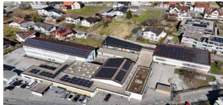
Fokus auf erneuerbare Energien: Der Campus aus dem Jahr 2019 wurde mit 200 kWp-Photovoltaik erweitert sowie eine Wärmepumpe eingebaut. (Bild Gemeinde Bludesch)
