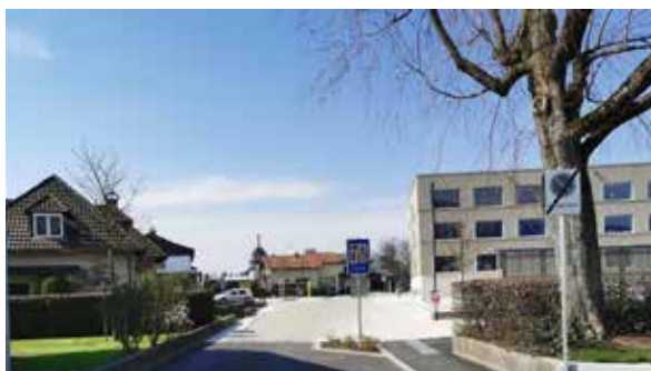
In Wolfurt wurde bei der Volksschule Bütze eine Fahrbahnverengung sowie eine anderer Fahrbahnbelag umgesetzt. © Marktgemeinde Wolfurt
