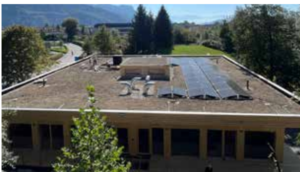
Eine Photovoltaik-Anlage mit 24 kWp Leistung liefert Sonnenstrom.
