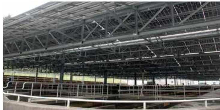
Die aufgeständerte PV-Anlage ist einzigartig in ganz Österreich. Ein PV-Dach mit 800 kWp Leistung liefert Sonnenstrom. Dazu wurden 1.864 Solarmodule installiert. Zusätzliche PV-Module befinden sich auf dem Dach der Nebengebäude.
