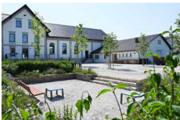
Sanierung des alten Vereinshaus Lauterach (© Marktgemeinde Lauterach)
