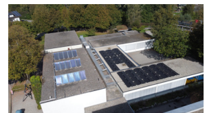
Kindergarten Brühl: 30 kWp
