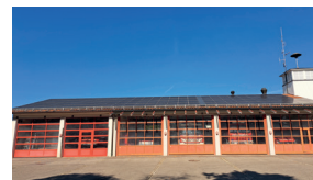
Feuerwehr Fahrzeughalle: 29,7 kWp
