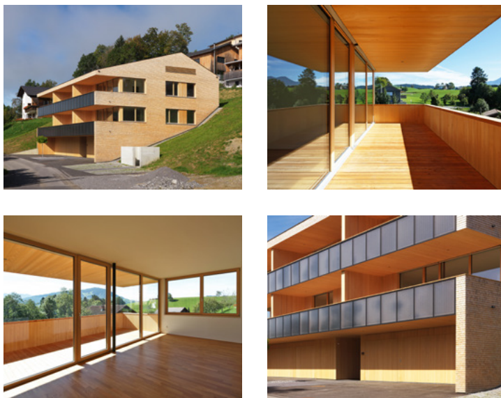
Abbildung 5: Wohnanlage Langenegg Unterstein, Morscher, Architektur H. Kaufmann
