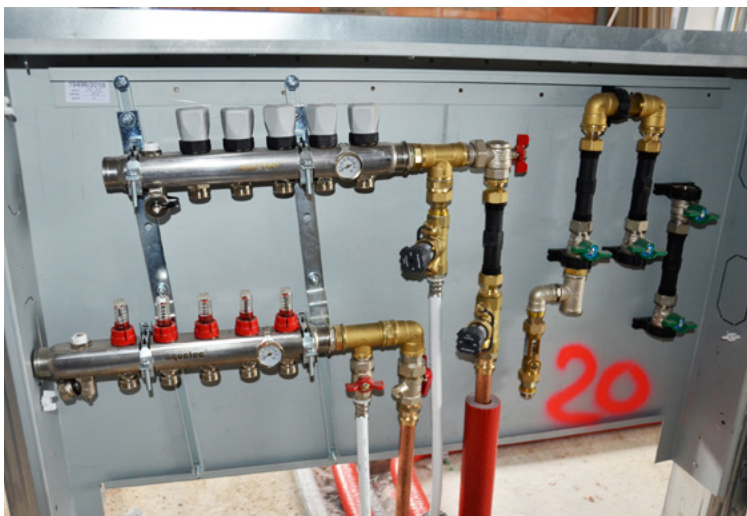
Abbildung 49: Baustellenfotos MFH „KliNaWo“ in Feldkirch-Tosters
