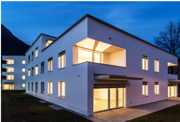
Abbildung 1: Das Netto-Null-Gebäude am Vögelebichl in Innsbruck, Außenaufnahme April 2015
