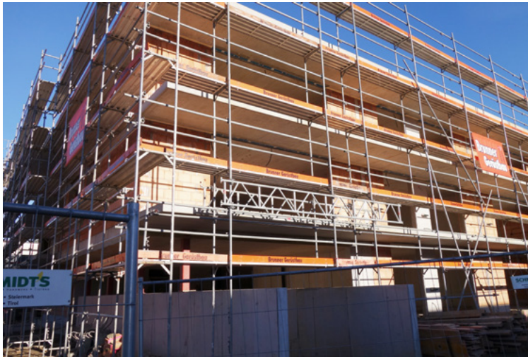
Abbildung 48: Baustellenfotos MFH „KliNaWo“ in Feldkirch-Tosters
