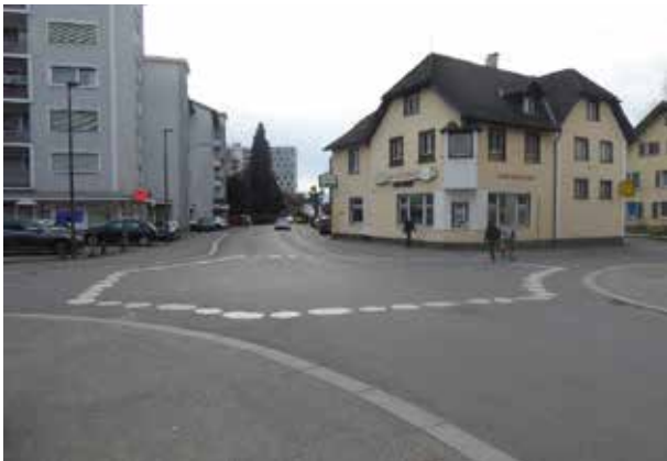
» Bodenmarkierungen im Kreuzungsbereich
