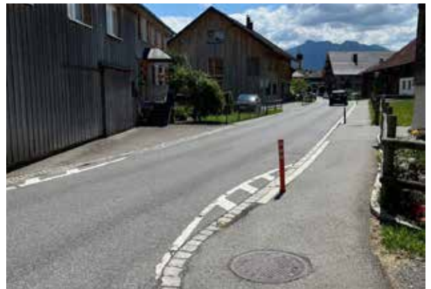
» Poller als Schutzmaßnahme für Fußgänger*innen
