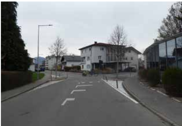
» Fahrbahneinengung mit Poller und seitlichen Inseln
