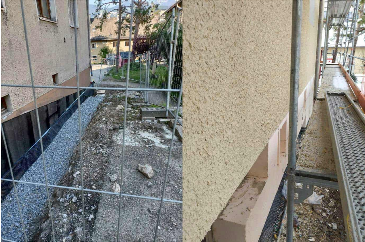
Abbildung 99: Verfüllung mit Schotter; verstärkte Dämmung im Sockelbereich – großes Gebäude; Fotos: Rhomberg Bau GmbH
