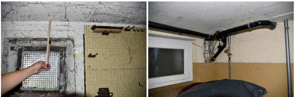
Abbildung 42: Kellerfenster und Kellerdecke, Fotos: Rhomberg Bau GmbH
