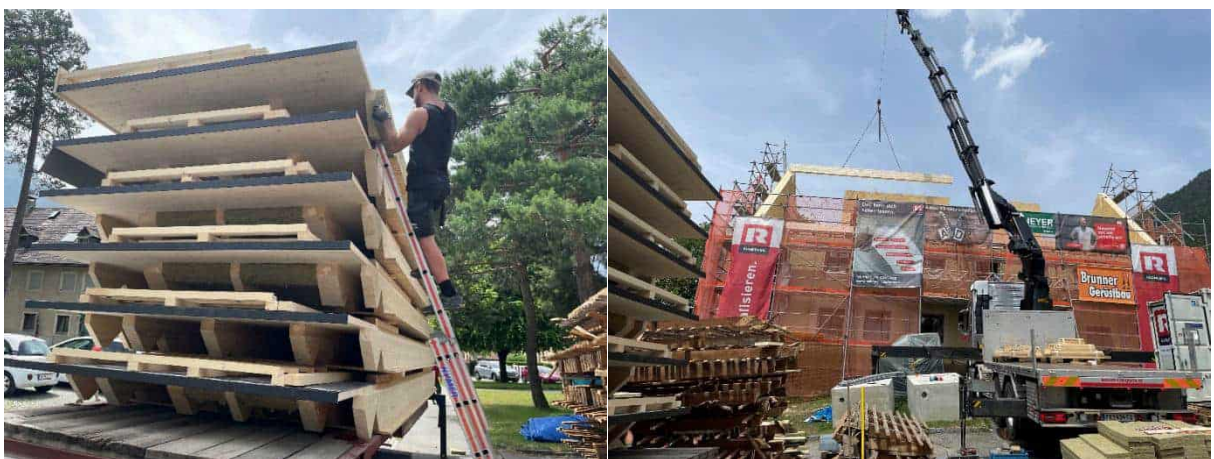
Abbildung 177: kleines Gebäude: vorgefertigte Dachelemente; Montage Firstpfette, Fotos: Rhomberg Bau GmbH
