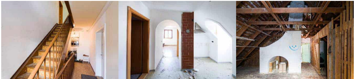
Abbildung 28: kleines Gebäude, Treppenhaus, Dachgeschoßwohnung und unbeheizter Teil Dachgeschoß (Fotos: Walser Fotografie, Hohenems)
