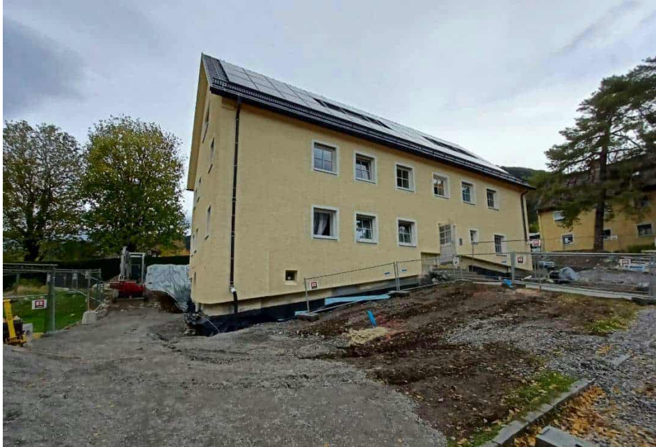
Abbildung 204: Geländemodellierung größeres Gebäude; Foto Rhomberg Bau GmbH
