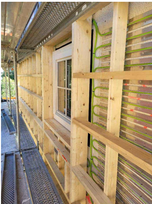
Abbildung 110: großes Gebäude: vorgefertigte Kreuzlagenelemente; Fotos: Energieinstitut Vorarlberg
