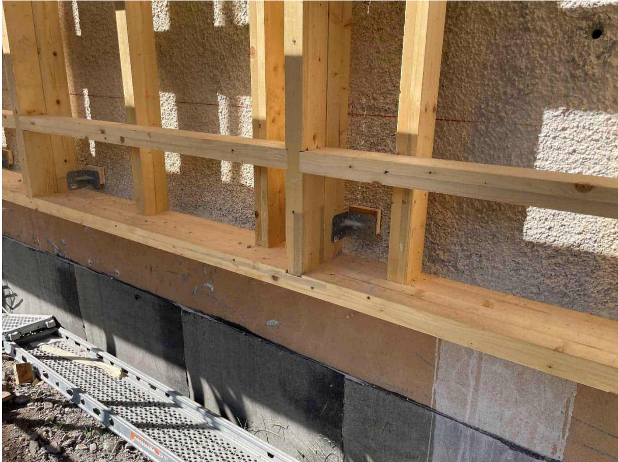
Abbildung 111: großes Gebäude: teil-vorgefertigte Kreuzlagenelemente; Foto: Energieinstitut Vorarlberg
