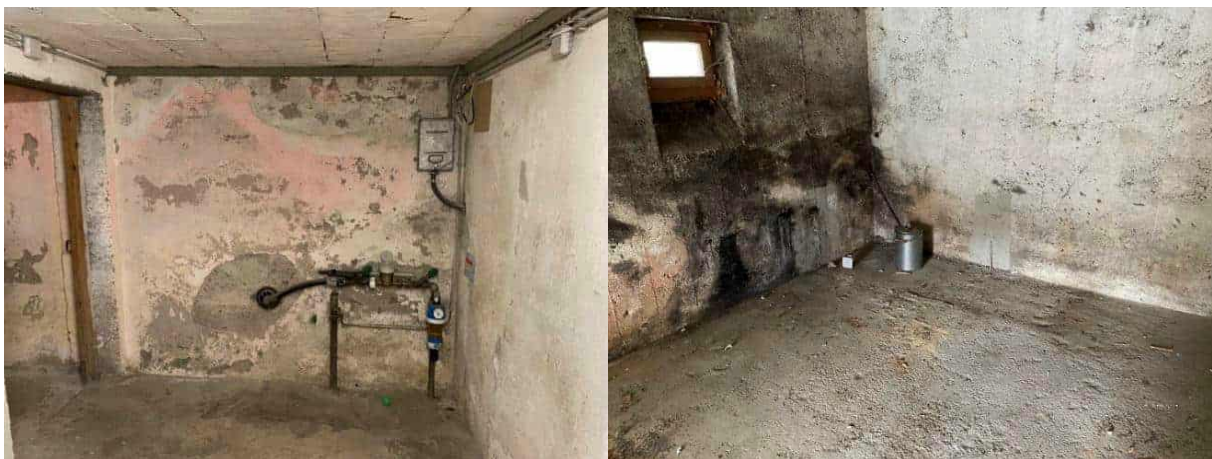
Abbildung 39: Kellergeschoß im kleinen und im großen Gebäudetyp, Fotos: Energieinstitut Vorarlberg
