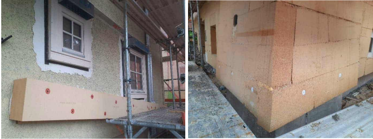
Abbildung 159: kleines Gebäude: Montage der Holzweichfaserplatten, Fenster in Dämmebene, Jalousiekasten (links); Ausführung WDVS an der Gebäudeecke; Fotos: Energieinstitut Vorarlberg
