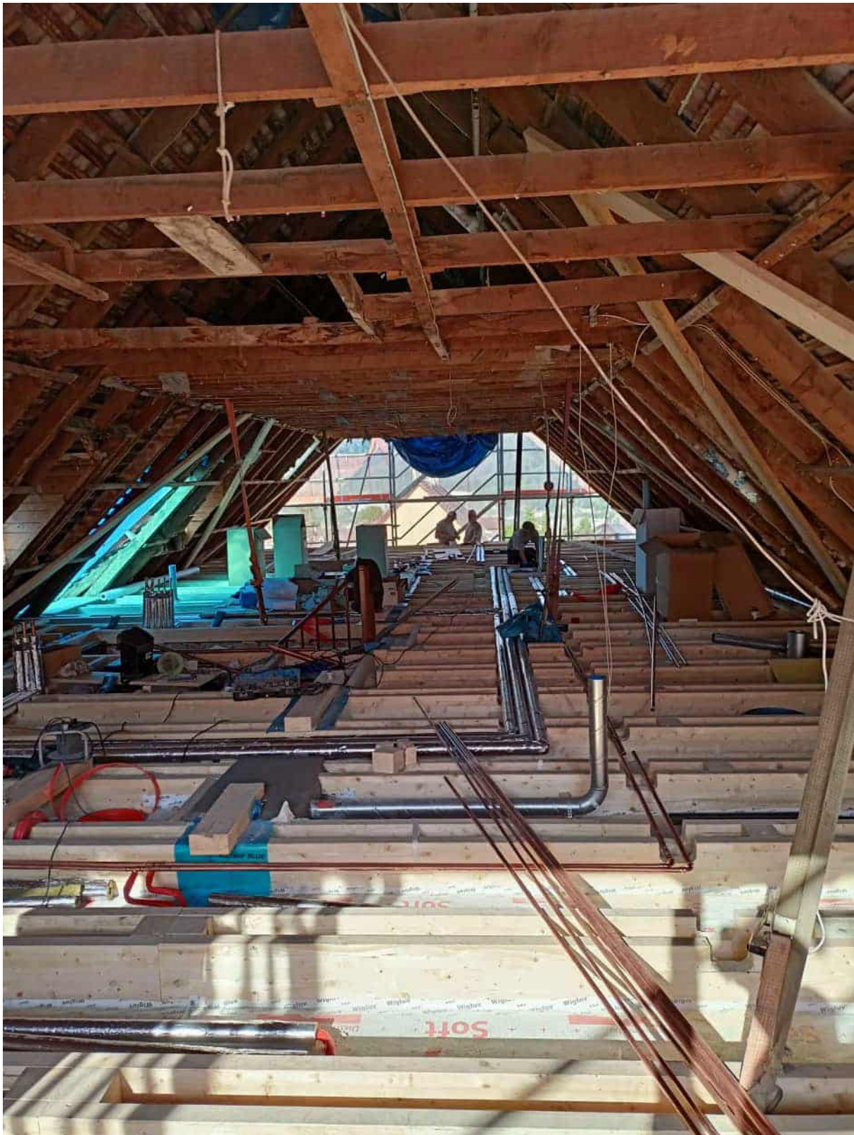
Abbildung 172: kleines Gebäude: Verstärkung oberste Geschoßdecke und Horizontalverteilung Lüftung im DG, Foto: Rhomberg Bau GmbH
