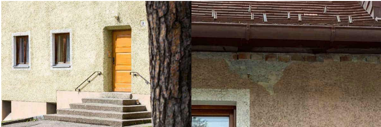
Abbildung 46: Status Quo der oberirdischen Außenwände im kleinen Gebäude – links, Foto Walser Fotografie, Hohenems und in einem weiteren Gebäude, Foto: Energieinstitut Vorarlberg
