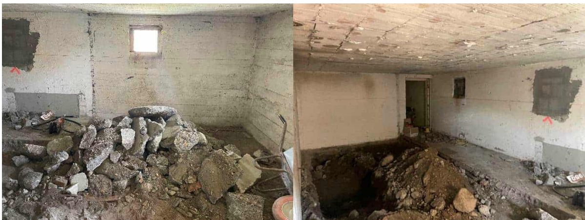
Abbildung 103: Arbeiten am Kellerboden; Fotos: Fotos: Rhomberg Bau GmbH
