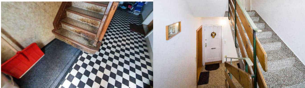
Abbildung 53: Treppenhaus im kleinen Gebäude – links, Foto: Rhomberg Bau GmbH und im großen Gebäude Foto: Walser Fotografie, Hohenems
