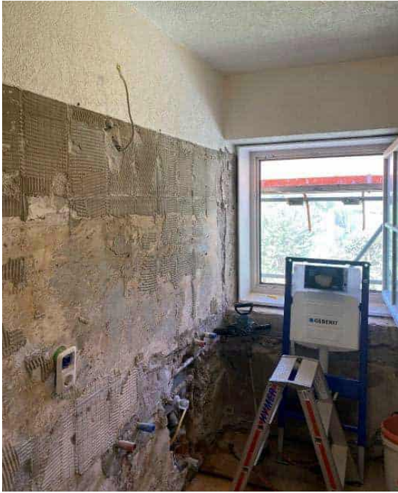
Abbildung 142: Badsanierung; Foto: Rhomberg Bau GmbH
