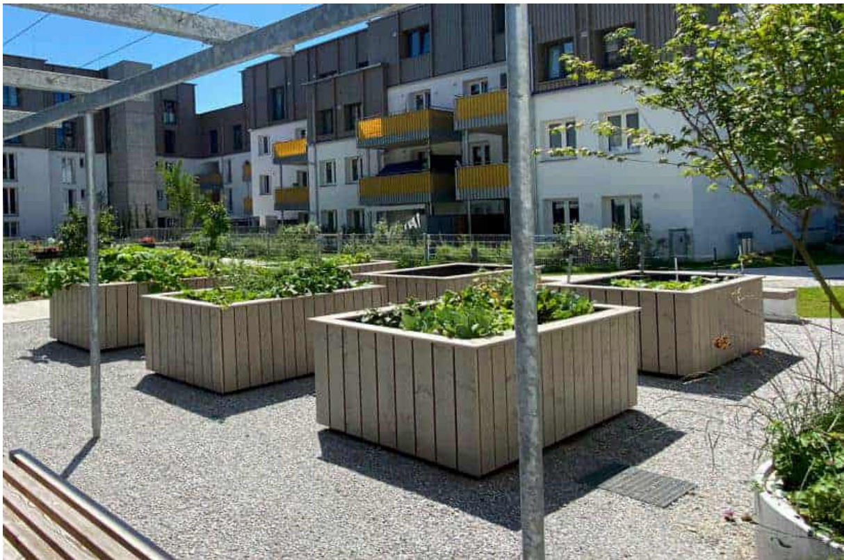
Abbildung 214: Wohnanlage Friedrich-Inhauser-Straße, Salzburg nach Sanierung; cs-Architektur mit stijn nagels architecture atelier; Foto: SIR
