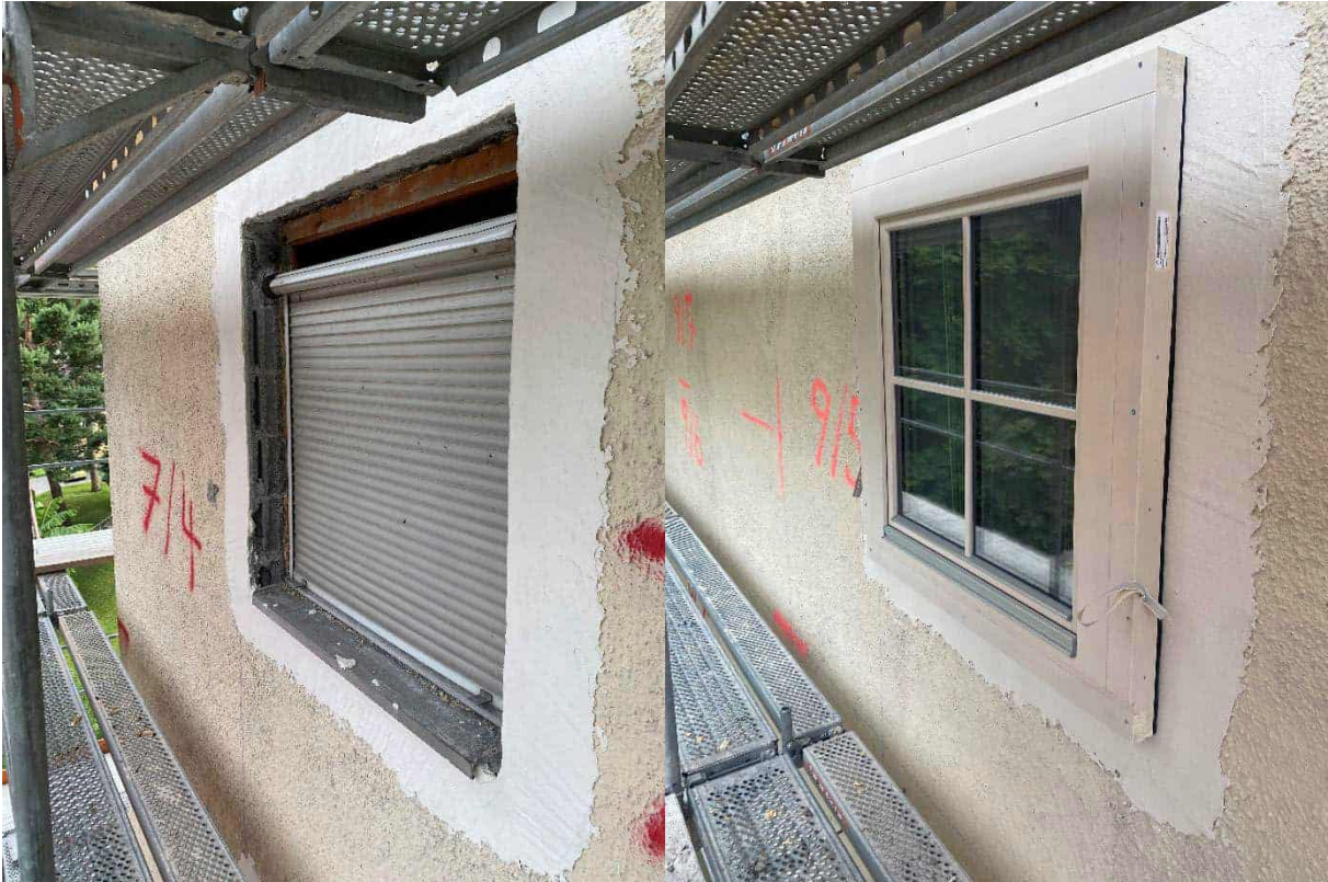
Abbildung 116: Glattstrich als Grundlage für das Verkleben der Fenster in der Dämmebene; eingebautes Fenster mit Holzrahmen und Wiener Sprosse; Foto: Rhomberg Bau GmbH
