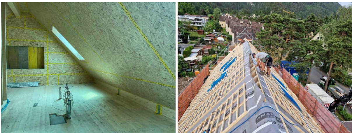
Abbildung 181: kleines Gebäude: abgeklebte Elementstöße; Lattung/Konterlattung; Fotos: Rhomberg Bau GmbH
