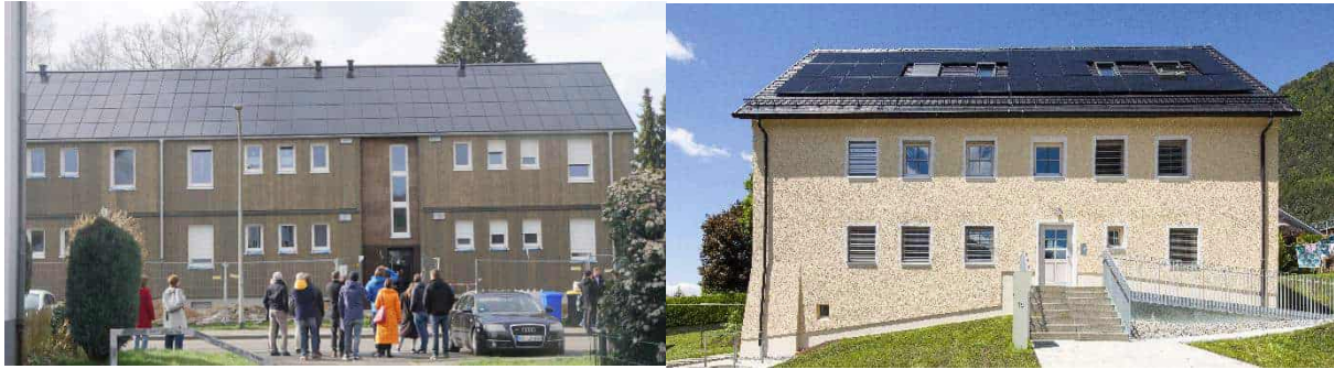
Abbildung 220: Ansicht der vollflächige Dachbelegung im Sanierungsprojekt Mönchengladbach und der weitestmöglichen Belegung des Dachs im kleinen Gebäude in Bludenz; Fotos: Energieinstitut Vorarlberg (links), Walser Fotografie, Hohenems (rechts)
