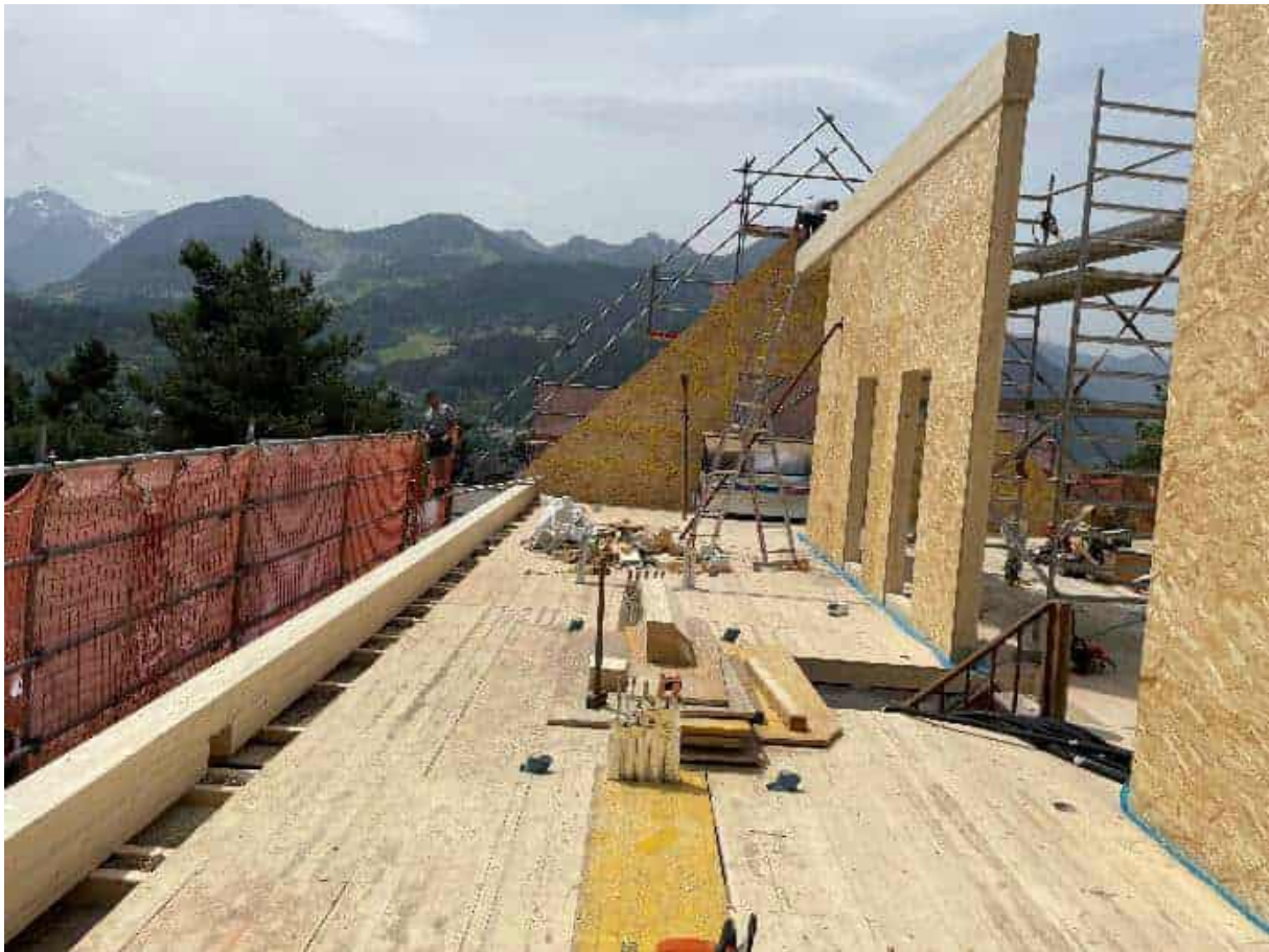
Abbildung 176: kleines Gebäude: DG nach Schließen der obersten Geschoßdecke und Montage der Giebelwand und der tragenden Innenwand; Foto: Rhomberg Bau GmbH
