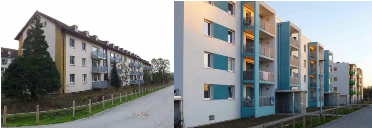
Abbildung 212: Mehrfamilienhaus “PassivhausSozialPlus” vor und nach Sanierung; Fotos: Institut Wohnen und Umwelt
