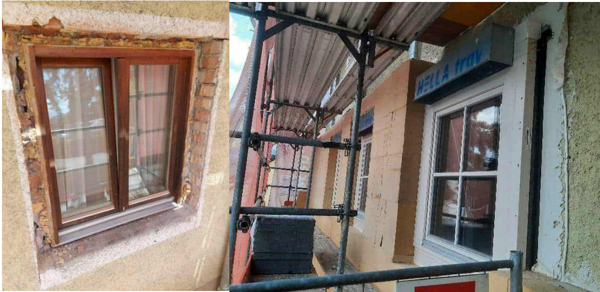
Abbildung 162: kleines Gebäude: Demontage der Fenster; Foto Rhomberg Bau GmbH; Fenster und Jalousiekästen; Foto: Energieinstitut Vorarlberg
