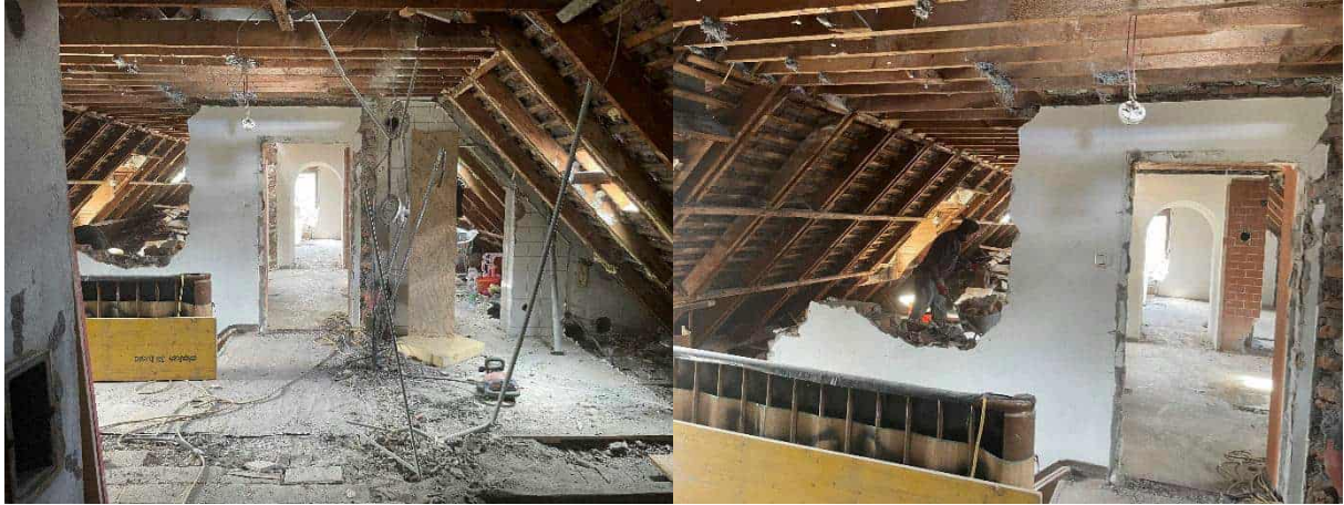
Abbildung 168: kleines Gebäude: Abbruch Dachgeschoß, Fotos: Rhomberg Bau GmbH
