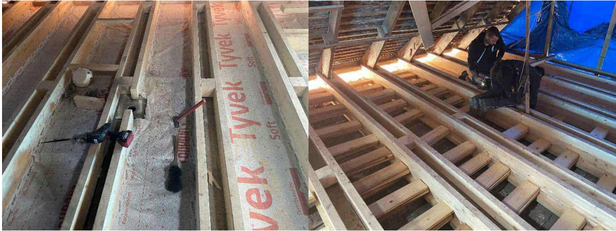
Abbildung 170: kleines Gebäude: Verstärkung der obersten Geschoßdecke, Foto: Rhomberg Bau GmbH
