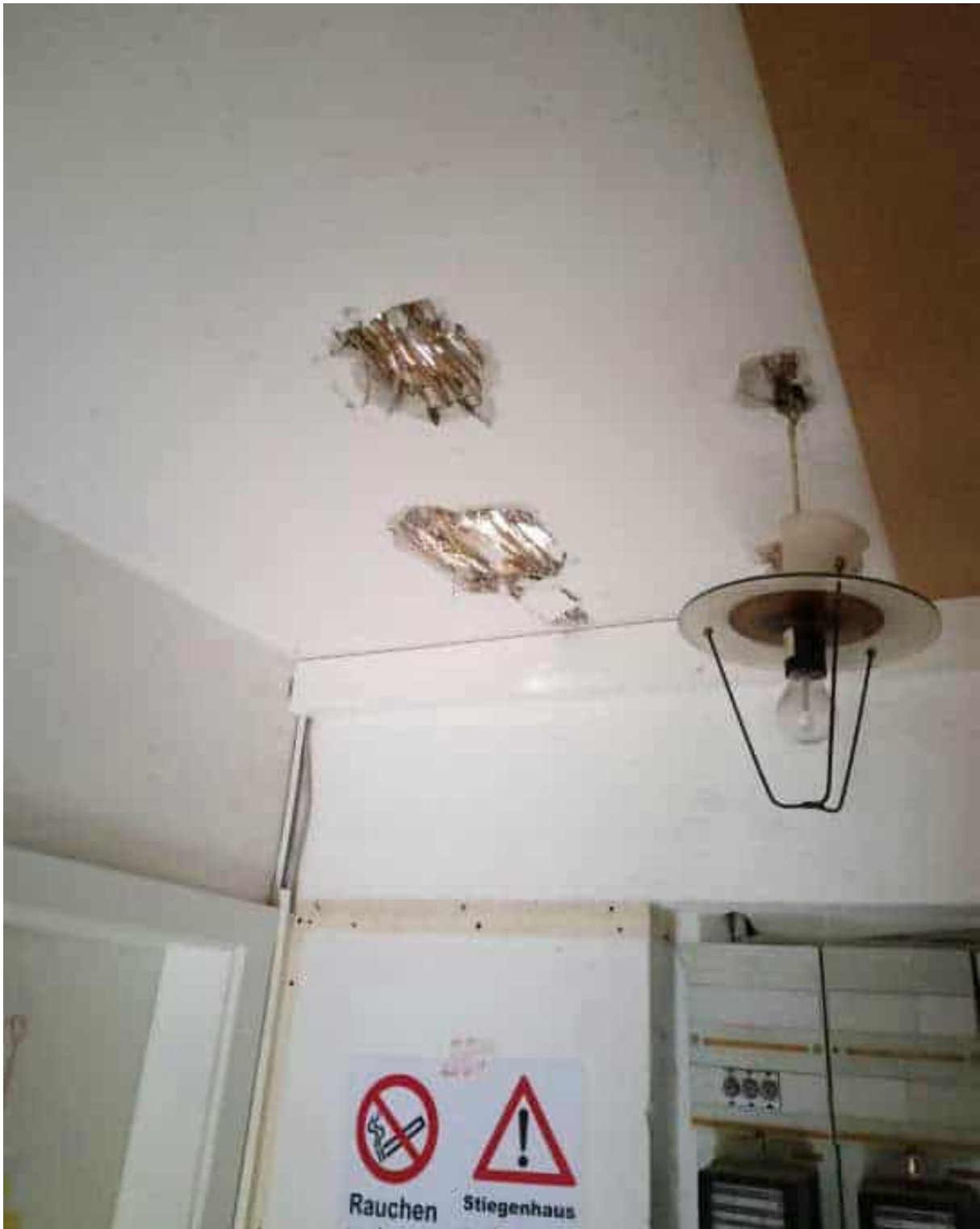
Abbildung 171: oberste Geschoßdecke während der Arbeiten zur Deckenverstärkung, Foto: Rhomberg Bau GmbH
