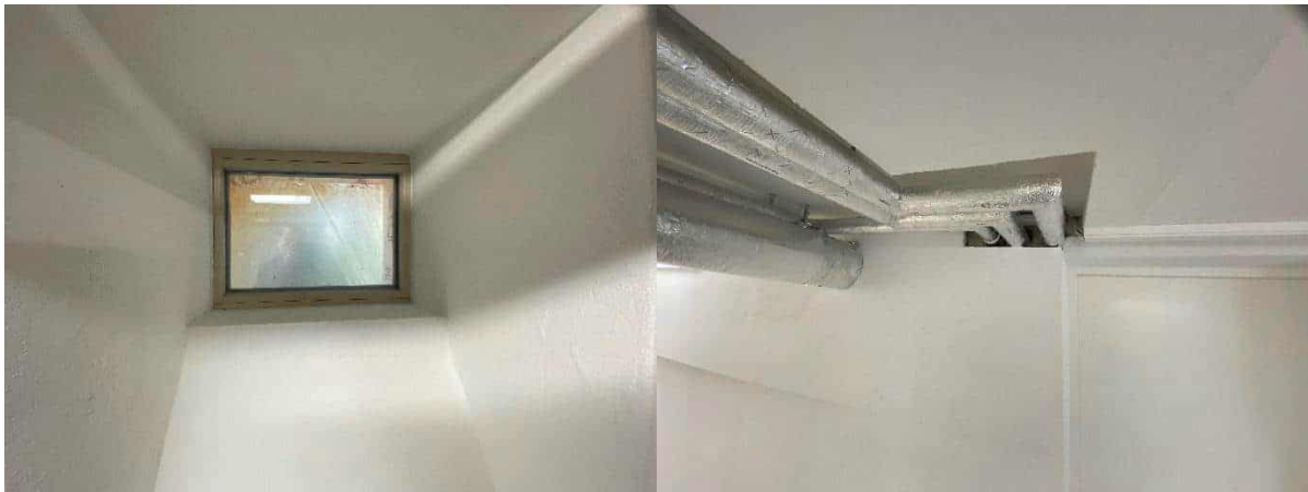
Abbildung 105: Neue Kellerfenster und Leitungsführung unter der Kellerdeckendämmung bzw. in der Dämmebene; Fotos: Energieinstitut Vorarlberg
