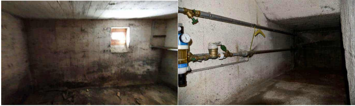
Abbildung 40: Kellergeschoss im kleinen Gebäude – links und im großen Gebäude, Fotos: Rhomberg Bau GmbH Bau GmbH
