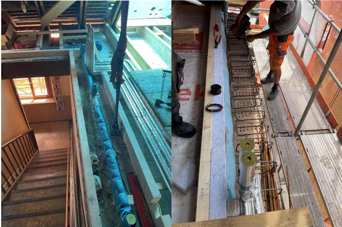
Abbildung 173: kleines Gebäude: oberste Geschoßdecke vor Schließen des Treppenhauses; giebelseitiger Anschluss an Bestands-Außenwand, Fotos: Rhomberg Bau GmbH
