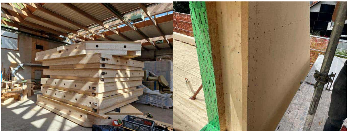
Abbildung 175: kleines Gebäude: vorgefertigte Giebelwandelemente in der Zimmerei und von außen nach Montage; Fotos: Rhomberg Bau GmbH
