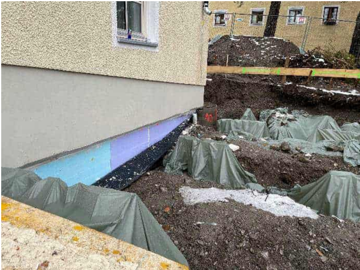
Abbildung 157: kleines Gebäude: Außenwand EG, Sockel und Außendämmung Kellerwand; Foto: Rhomberg Bau GmbH
