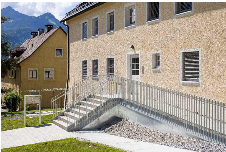
Abbildung 205: neue Erschließungstreppe und Rampe; Foto: J. Walser Fotografie, Hohenems
