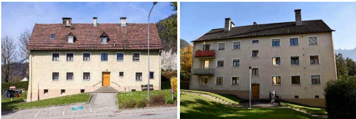
Abbildung 1: Das kleinere und das größere Gebäude vor Sanierung; Fotos: Walser Fotografie, Hohenems, M. Fortenbacher
